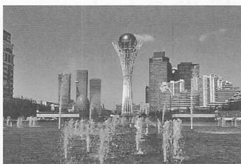
▲カザフスタン独立の象徴として建てられた「バイテレク」
