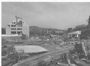
▲被災した建物
