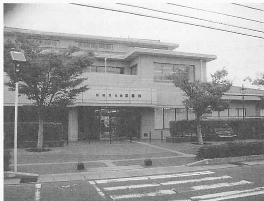
▲道路に面した旧正面入口（現在は使われていない）
