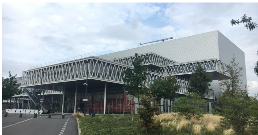
フランス国立文書館新館 (ピエールフィット=シュル=セヌ館) Project by Massimiliano and Doriana Fuksas - ©Yashiho Kikkawa
