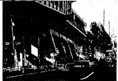
▶崩壊した山陽新幹線の高架部分
