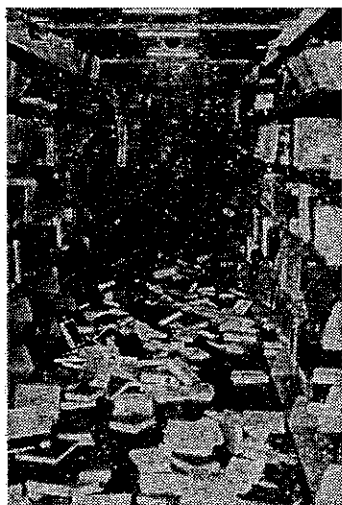
写真2 (上) 整理事務室 写真3 (左) 開架閲覧室 書架の倒伏と圖書の落下の状況 東側ブロック(いずれも東北大)
